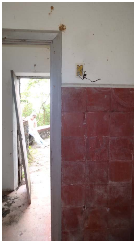
Fig. 3: Caixa de interruptor aparente.
