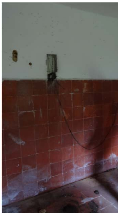
Fig. 2: Fiação aparente sem proteção.
